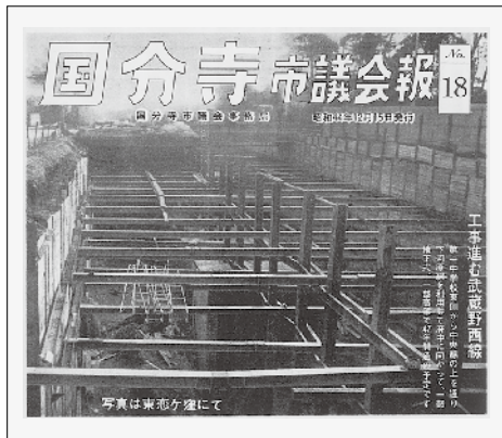
市議会報18号 昭和44年12月15日号 工事進む武蔵野線
