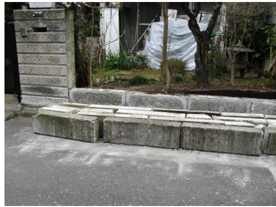
《市内で発生した塀の倒壊(3月11日)》
