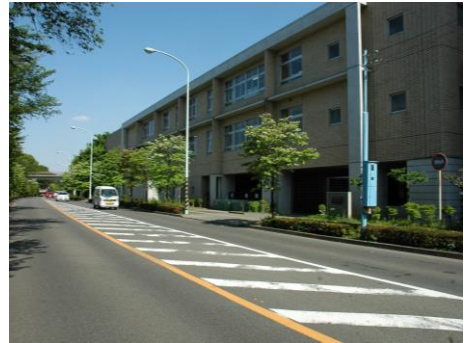
■地区防災センター（第四小学校）に接続する国3・4・3号線（多喜窪通り）
