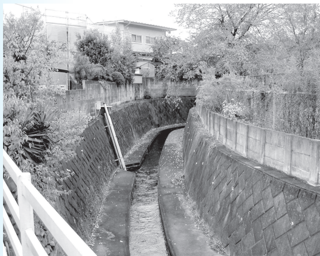
鞍尾根橋付近の野川（国分寺市側）
