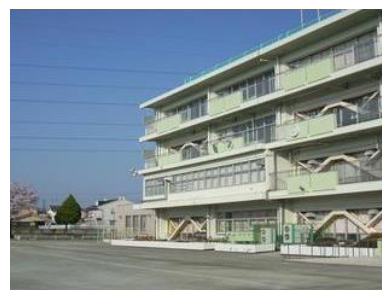
■地区防災センター（第十小学校）
