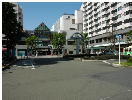
■ 西国分寺駅南口駅前広場
