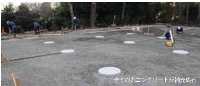
中門跡の工事風景（北から）
