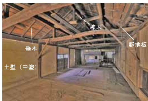
解体前の長屋門二階・小屋組（西から）（平成 26 年 12 月撮影）
