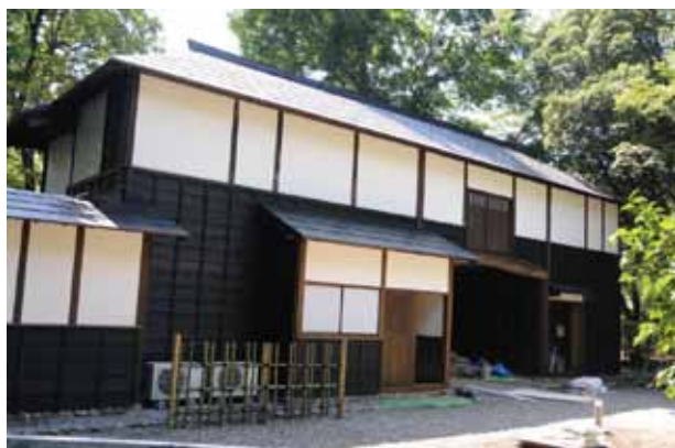
長屋門外観（北から）
