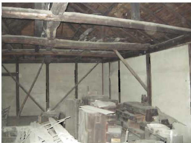
旧本多家住宅長屋門二階の整理前状況（平成5年3月）
