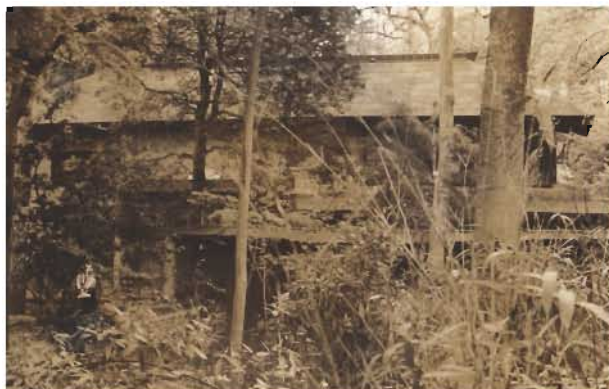
旧本多家住宅長屋門（昭和40年代頃）南から
