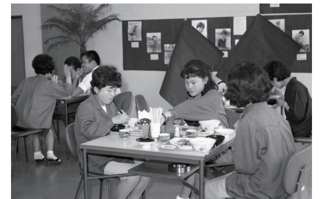
市役所内地下食堂 昭和40年(1965) 面積約147.6㎡、48人分のテーブルを用意、そば、和定食、カレーライス、その他タバコなども販売していました。
