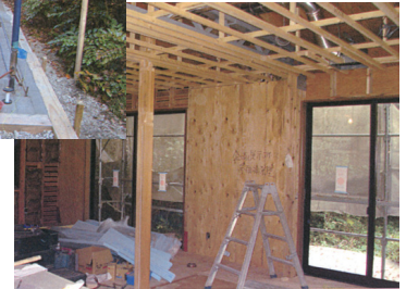
改修工事の様子
