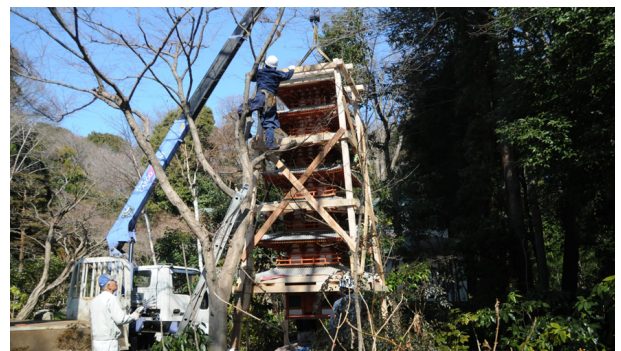
クレーン車で設置
