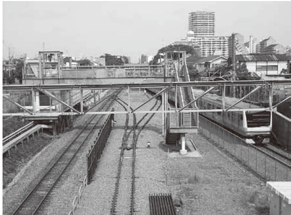
↑内藤橋から西国分寺駅方向を望む
