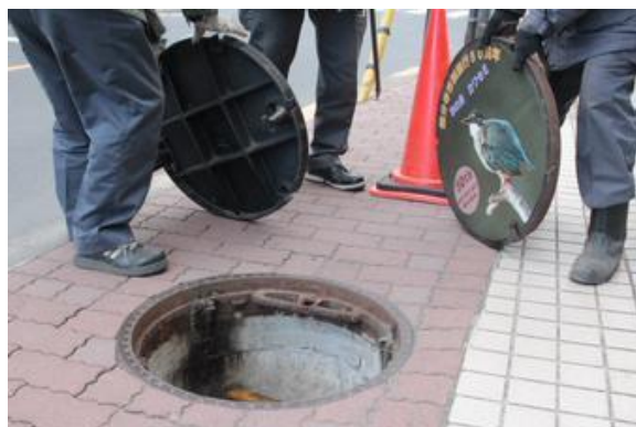
図表 人孔蓋の点検の様子
