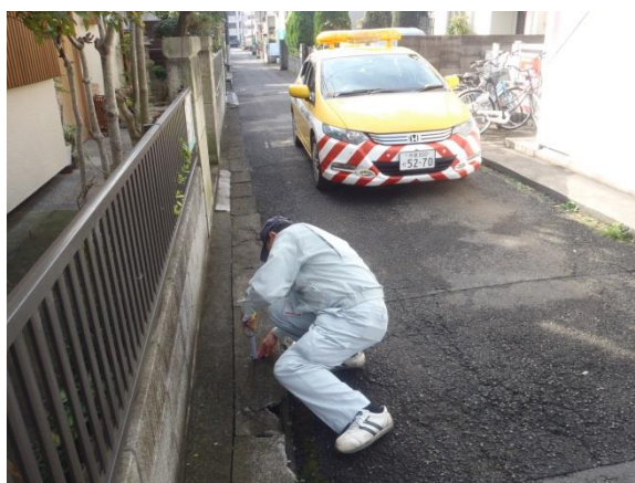
図表 市内での道路パトロールの様子
