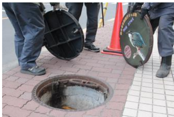
図表 人孔蓋の点検の様子
