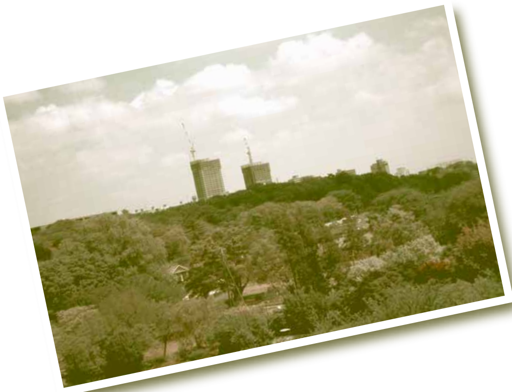
国分寺の自然と建設途中の国分寺駅北口再開発ビル
