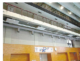
体育館にエアコンを設置しました
