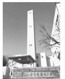
国分寺市清掃センター
