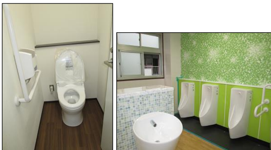
トイレ改修事例（第二中学校，第五中学校）
