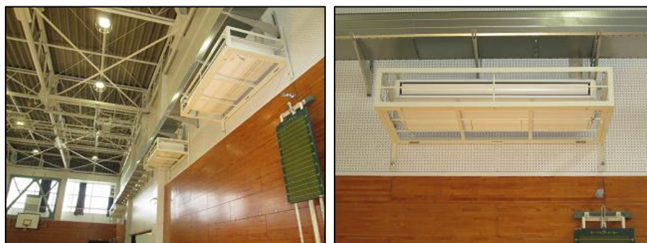
体育館エアコンの整備事例（第一中学校）
