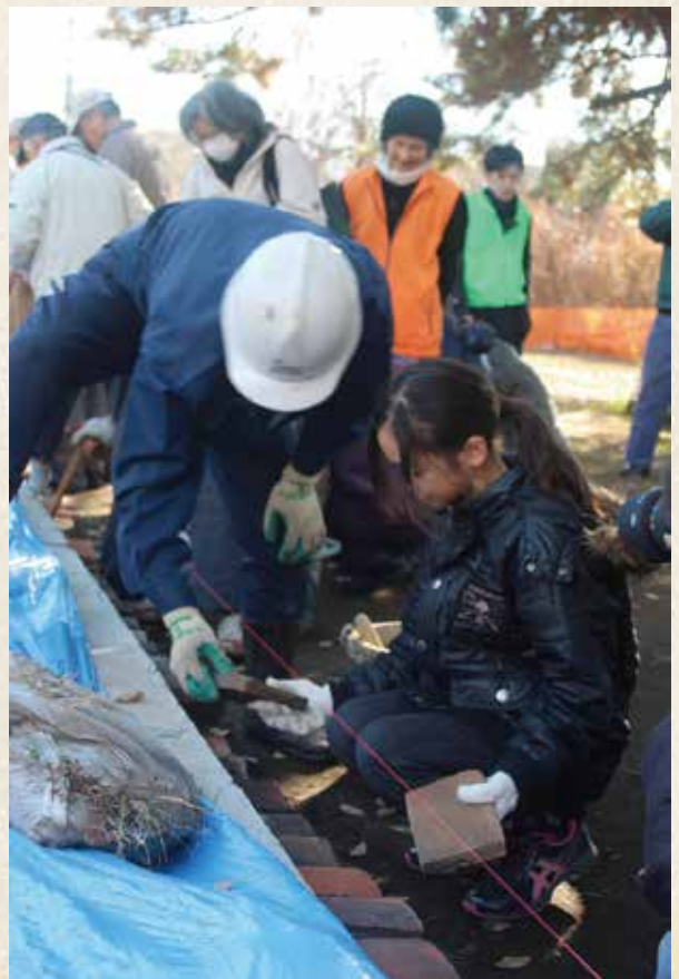
手作り瓦を基壇に埋め込む作業の様子
