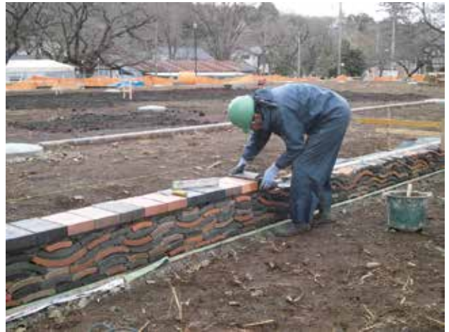
瓦積基壇復元整備工事の様子(平成25年度施工)
