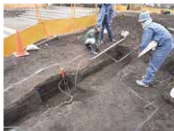
工事立会状況 (白線部分が粘土検出範囲)
