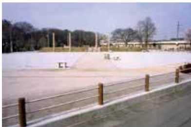
幡竿と金堂基壇(南から)
