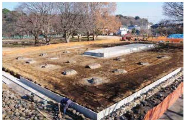
整備工事の様子（南西から、平成 29 年 12 月撮影）
