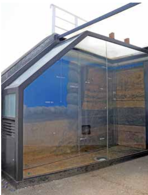
金堂基壇版築観察施設(西から)
