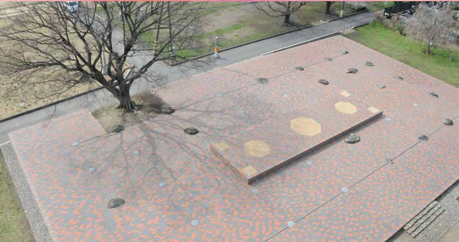
整備完了後の金堂基壇（北東から）
