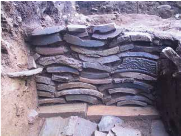
発掘調査で検出された再建時の瓦積基壇外装(北面中央付近、左ページ◀②印)
