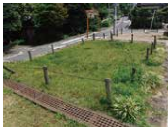
遺構保護状況
