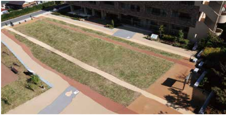
東山道武蔵路(西元町地区)整備状況(南西から)
