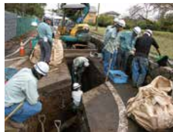
工事立会状況
