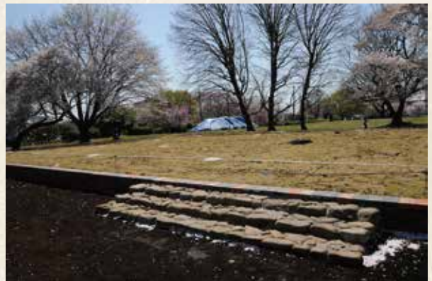
各地の発掘調査現場出土石材を活用して整備した階段
