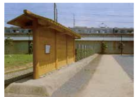
復元した掘立柱塀(南西から)
