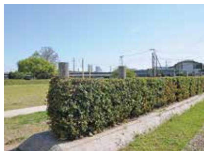
掘立柱塀(南西から)
