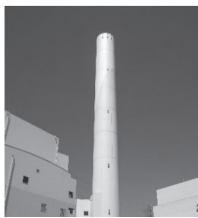
高さ85mの大煙突
