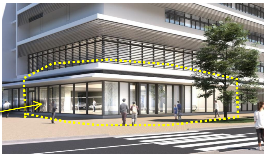
エントランス前の大庇の柱をなくし、視認性・歩行性とも向上させます。
