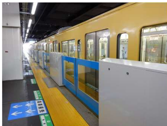
図 5-5 西武国分寺線国分寺駅ホームドア
