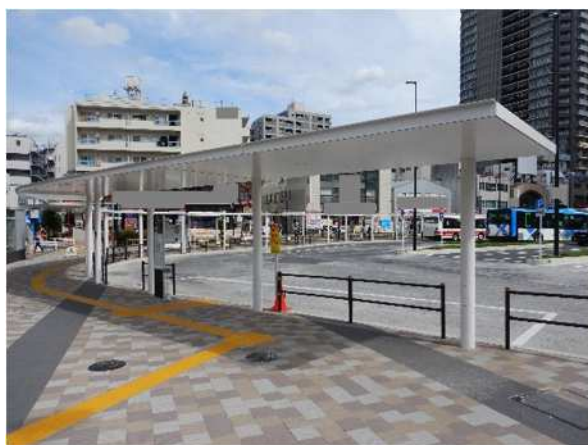
図 5-23 国分寺駅北口駅前広場
