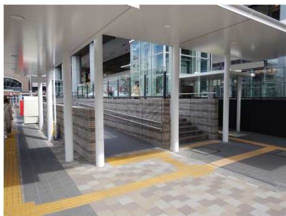
図 5-6 国分寺駅北口スロープとエレベーター
