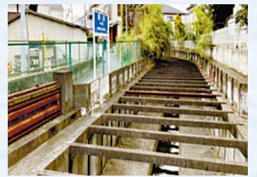
▲国分寺市エリアの野川(コンクリート3面張り)
