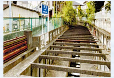
▲国分寺市エリアの野川(コンクリート3面張り)
