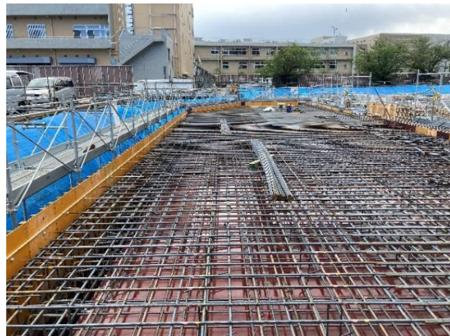
スロープ屋根部分は綺麗に配筋されています。型枠内は清掃され、良好に管理されています。(4/17)
