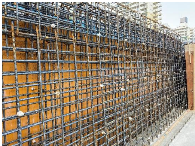
B1階 壁立上り配筋は構造図通り組まれていることを確認しました (4/17)
