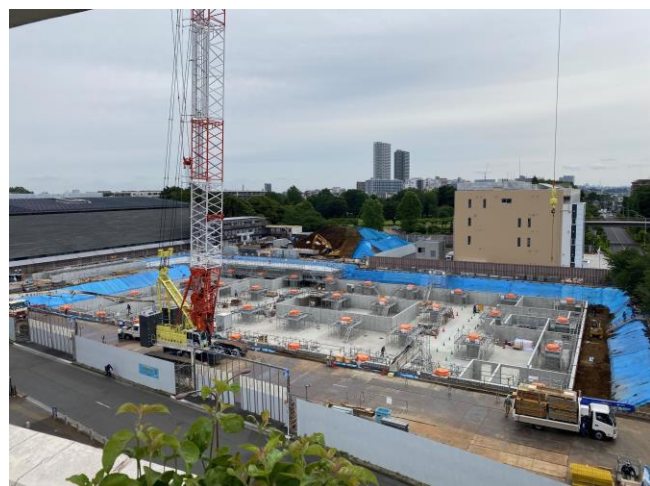
いずみプラザ屋上からの全景 (5/26)
