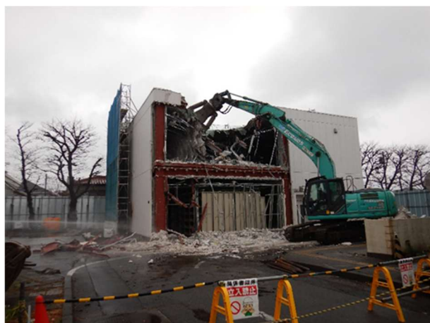
旧書庫棟 上屋解体状況
