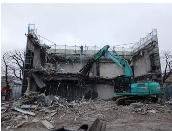
旧書庫棟 上屋解体状況
