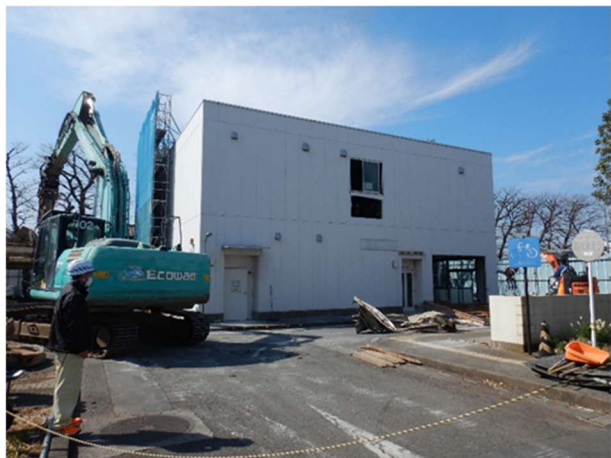
旧書庫棟 解体前
