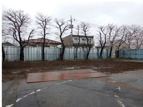
旧書庫棟 解体完了 (令和 7 年 3 月 31 日)
