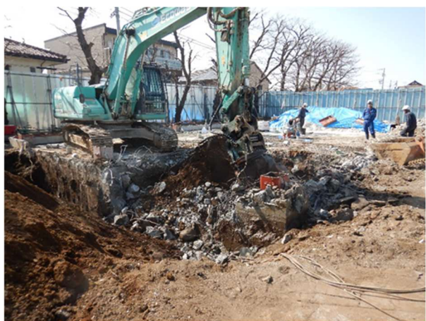
旧書庫棟 基礎解体状況
