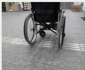
一部に15cmの隙間を設け、車いすやベビーカーが横断しやすい誘導ブロックを配置
