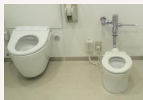
子ども用便器の設置
